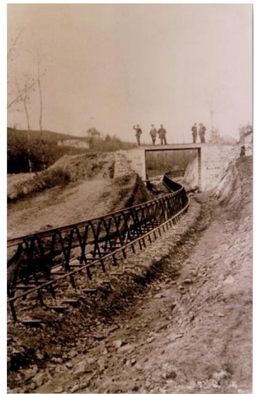
Le rail unique est porté à 90 cm du sol sur des chevalets assez rapprochés. De chaque côté, à 60 cm, est fixé un rail-guide contre lequel roule un galet à gorge destiné à maintenir l'équilibre du wagon et de la locomotive. Celle-ci comme les wagons est en deux parties. La communication d'un côté à l'autre se fait par un escalier à découvert et une superbe impériale. Le franchissement des routes, rivières et chemins demande une cinquantaine d'ouvrages d'art en granit taillé, encore tous visibles.
