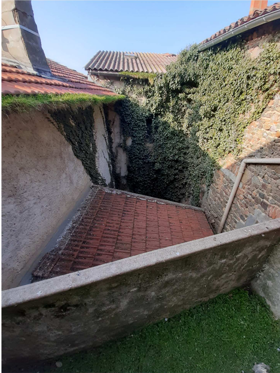
Figure 17 : Vue du cœur d'îlot depuis la fenêtre du logement situé au 27 ou 29 rue Paul Bert (EPORA)
