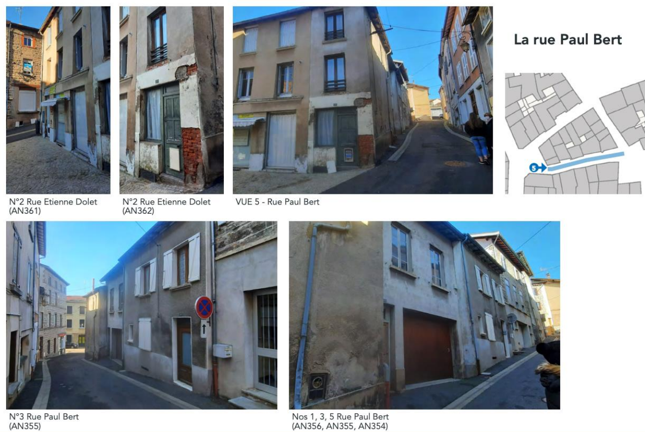
Figure 14 : Façades sur rue Paul Bert – état actuel (Zeppelin 2022)
