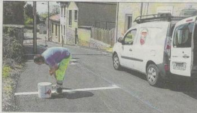
Bertrand Maillavin termine le marquage au sol. Photo Progrès/Alain BLEIN
