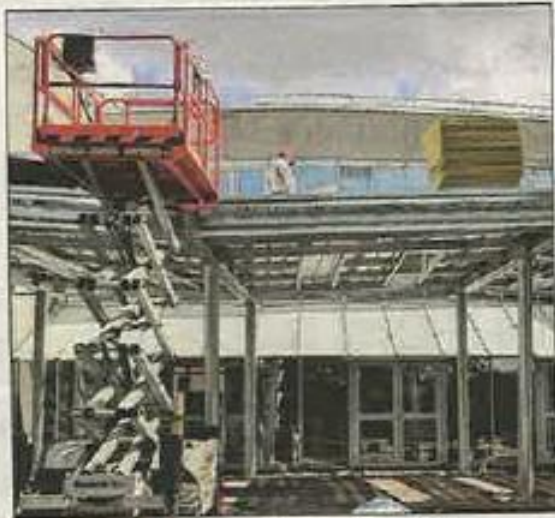
■ La construction d'un nouveau préau encore en travaux. Photo Samira COUCHAUD
