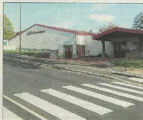
■ Le boulevard des Sports a été rénové. Photo Samira COUCHAUD
