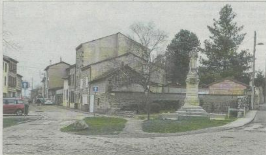
Une partie de la place de la Liberté va être le plus gros chantier. Photo Progrès/Alain BLEIN
