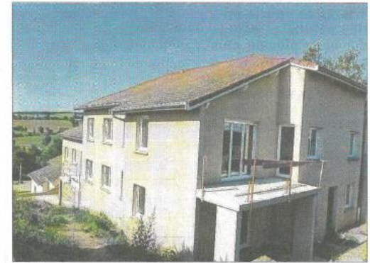
L'ancienne gendarmerie abritera huit logements tout confort.
