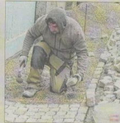
Les travaux vont bon train.
